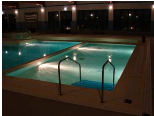
Foto post intervento
