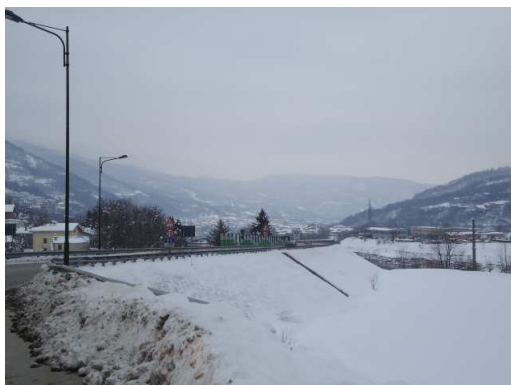
Foto post intervento
