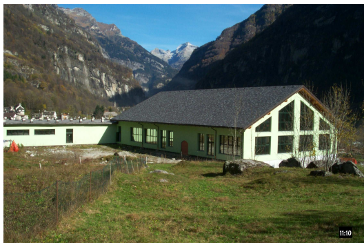
Foto pre intervento
