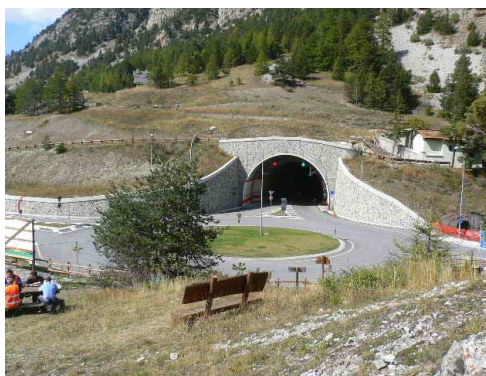
Foto post intervento
