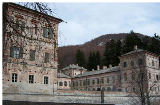
Foto pre intervento
