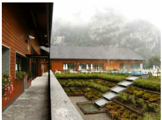
Foto post intervento
