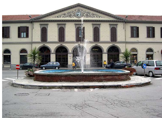
Foto pre intervento
