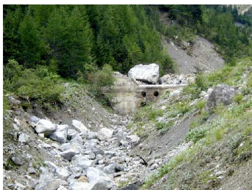
Foto pre intervento
