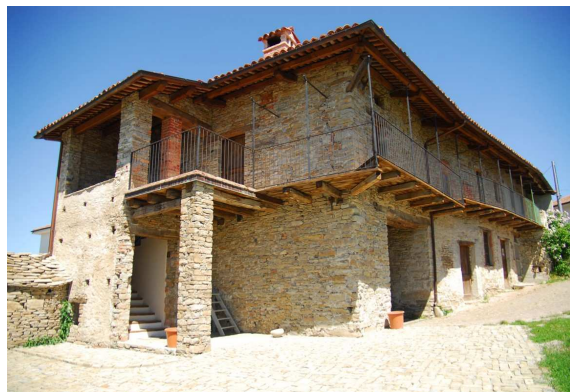
Foto post intervento
