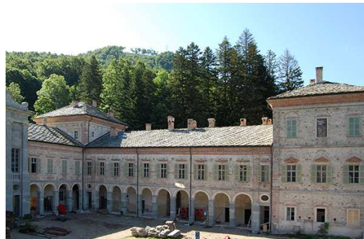
Foto post intervento
