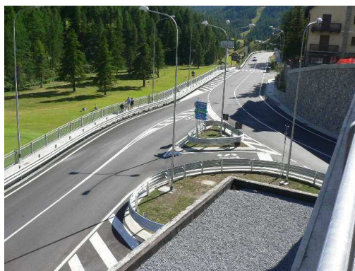
Foto post intervento
