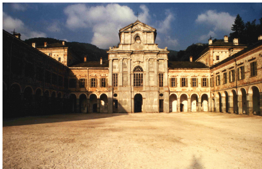
Foto pre intervento
