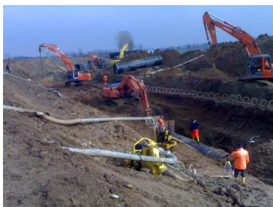
Foto post intervento
