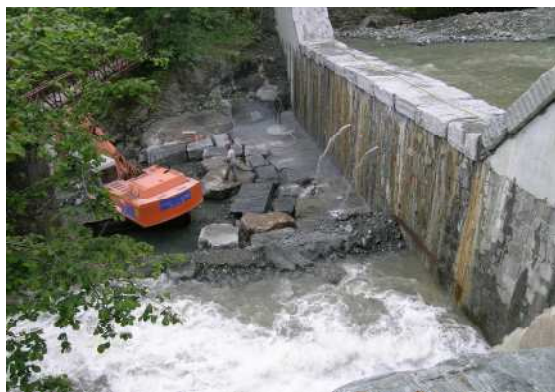
Foto durante esecuzione lavori: riparazione di una briglia
