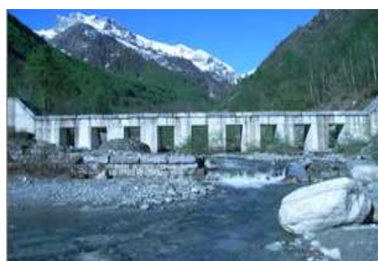
Foto post intervento: realizzazione della briglia selettiva
