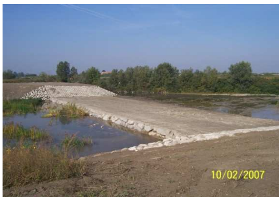
Foto post intervento
