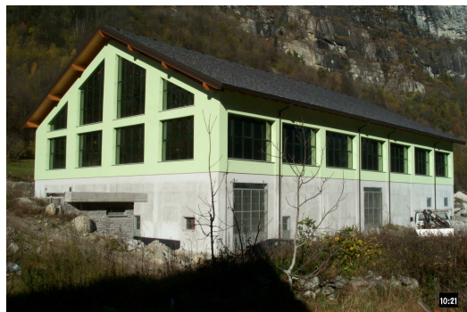
Foto pre intervento
