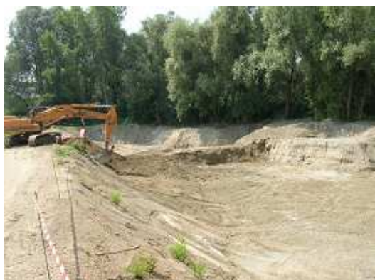
Foto pre intervento
