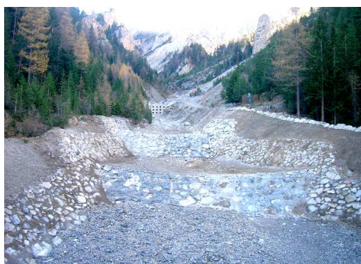
Foto post intervento
