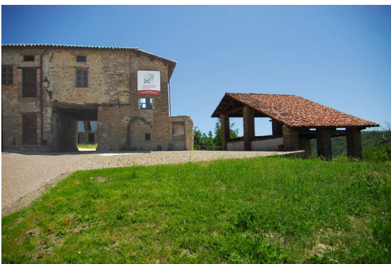
Foto post intervento
