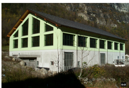
Foto pre intervento
