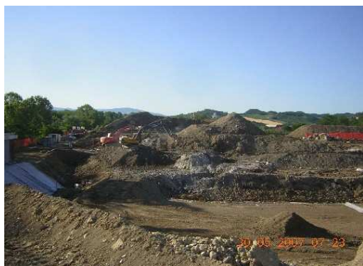
Foto pre intervento
