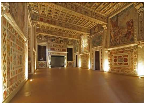
Foto post intervento
