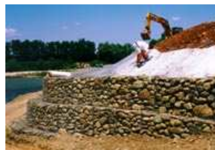
Foto post intervento
