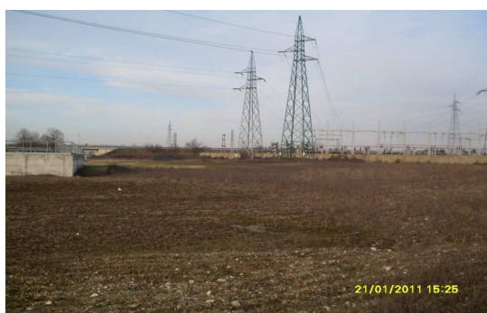
Foto prima dell'intervento
