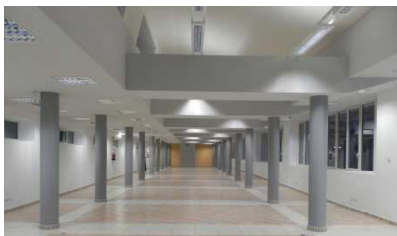
Vista interna sala lettura piano primo dopo l'intervento
