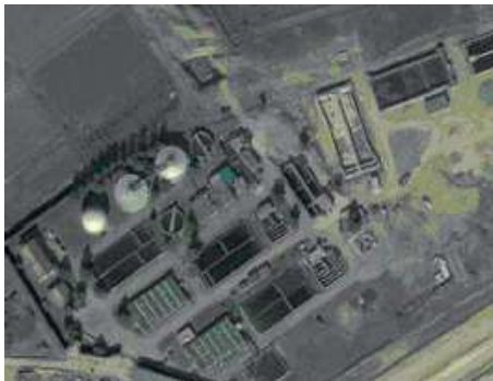
Foto pre intervento
