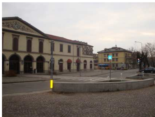
Foto post intervento
