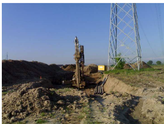
Foto pre intervento
