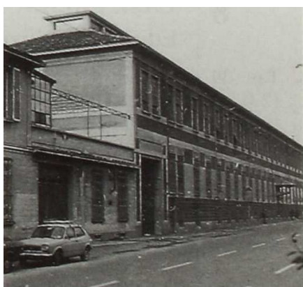
Foto pre intervento
