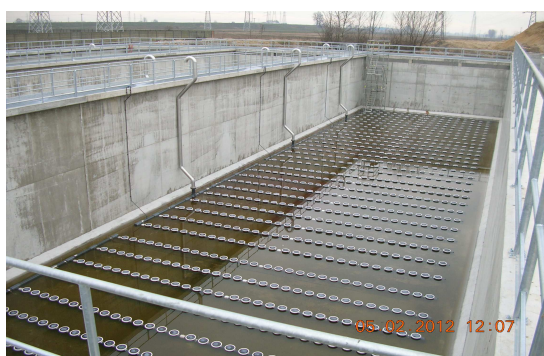
Foto durante l'intervento
