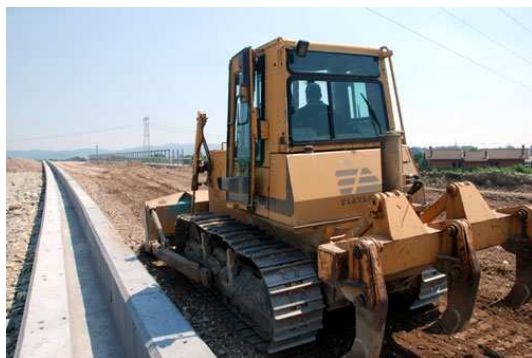
Foto pre intervento
