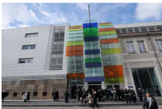
Foto post intervento
