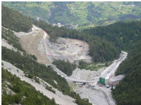
Foto intervento in corso
