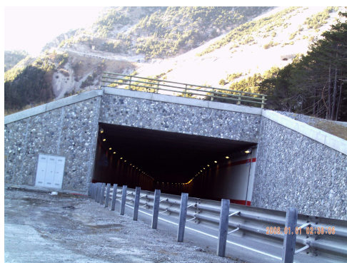
Foto post intervento
