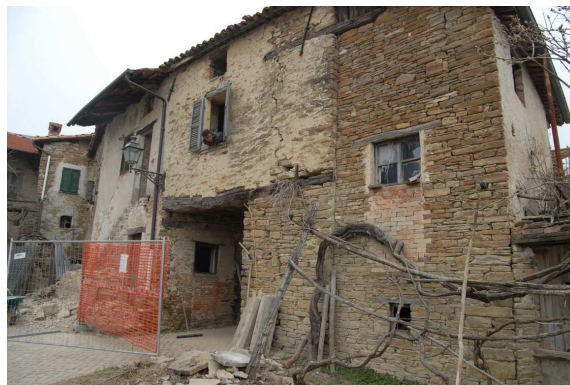
Foto pre intervento
