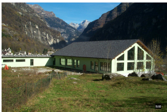
Foto pre intervento
