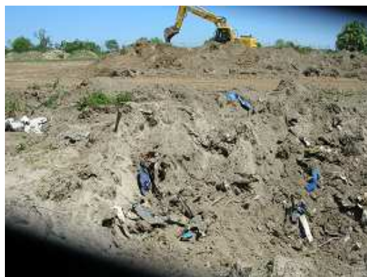
Foto pre intervento
