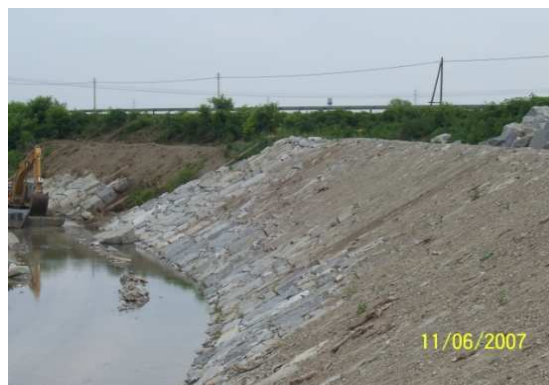
Foto post intervento
