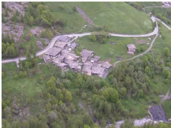
Foto pre intervento
