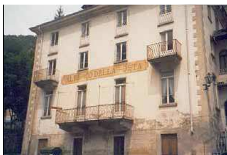
Foto pre intervento
