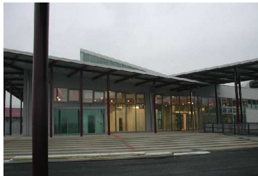
Foto post intervento
