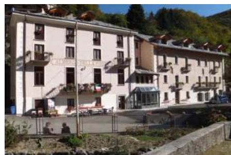
Foto post intervento
