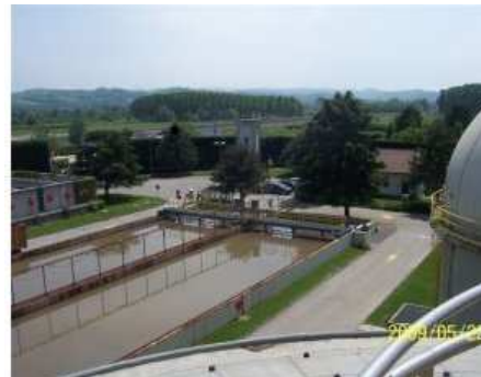
Foto post intervento
