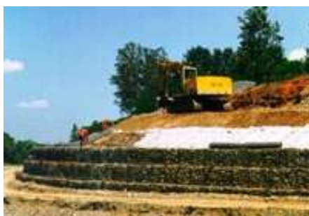
Foto post intervento
