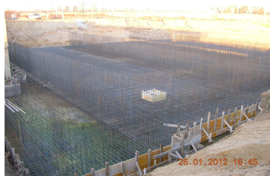
Foto durante l'intervento
