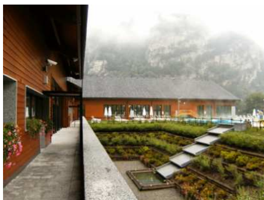
Foto post intervento
