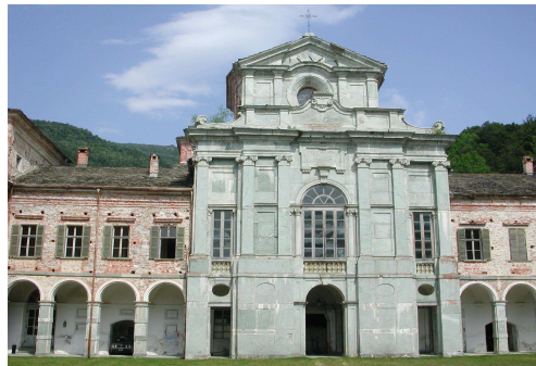
Foto post intervento
