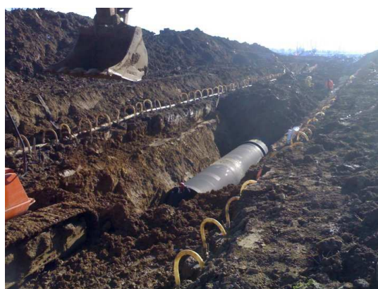
Foto post intervento
