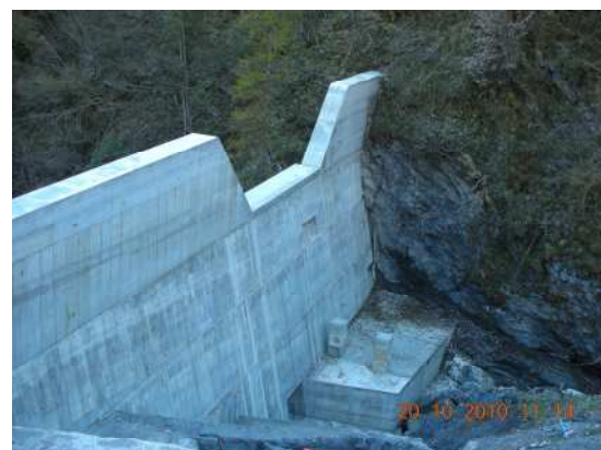
Foto post intervento
