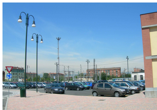
Foto post intervento
