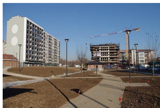
Foto post intervento
