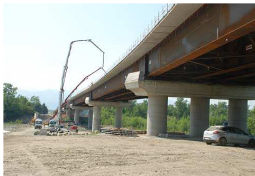
Foto pre intervento
