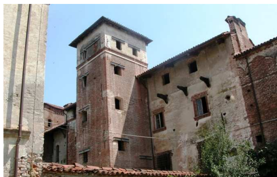
Foto pre intervento
