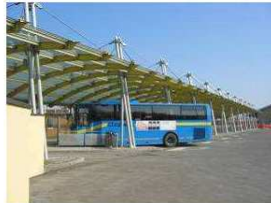
Foto post intervento
