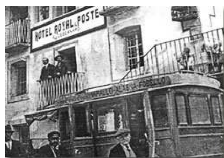
Foto pre intervento
