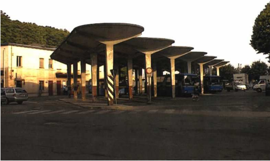
Foto pre intervento
