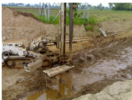
Foto pre intervento
