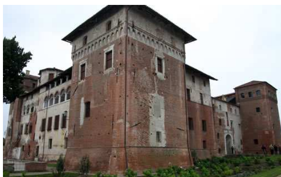
Foto post intervento
