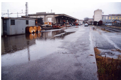
Foto pre intervento
