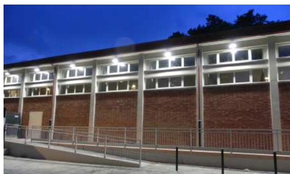
Vista frontale dopo l'intervento
