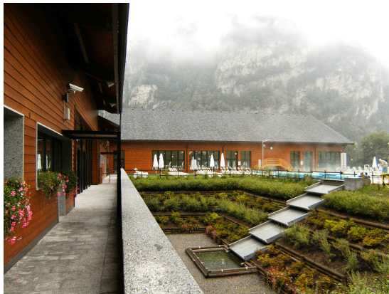
Foto post intervento
