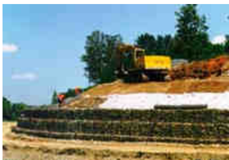
Foto post intervento
