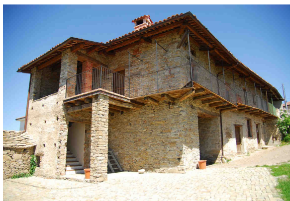
Foto post intervento
