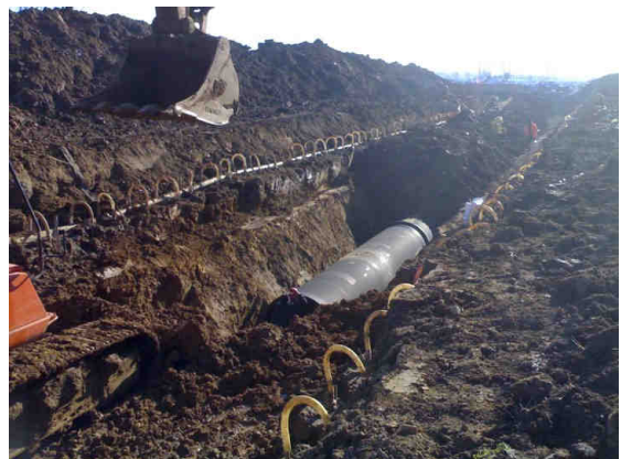
Foto post intervento
