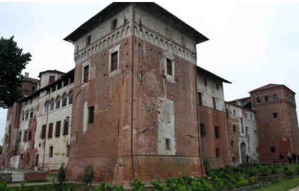
Foto post intervento
