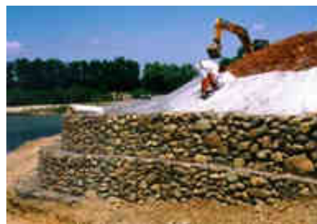
Foto post intervento
