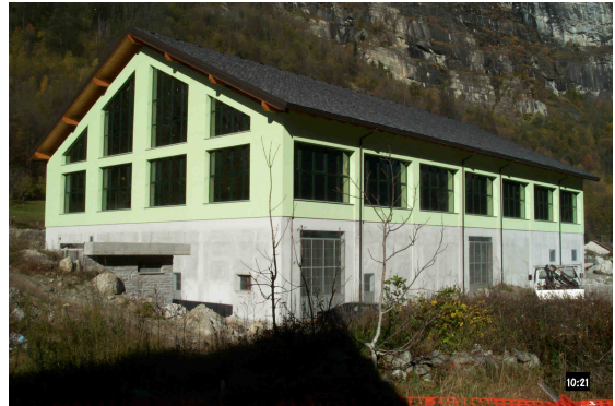
Foto pre intervento
