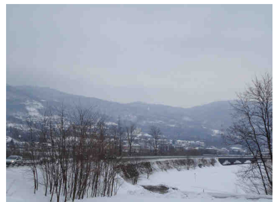
Foto post intervento
