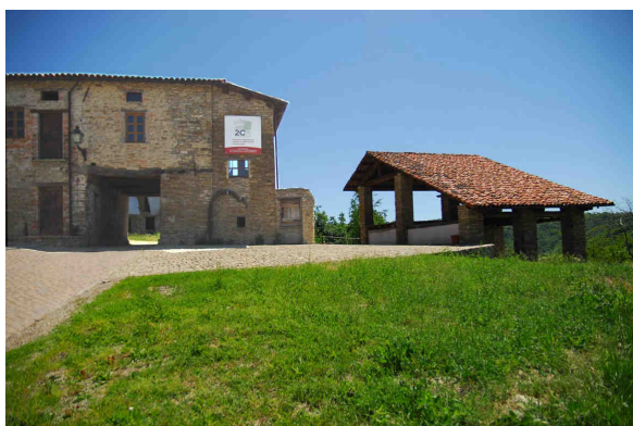
Foto post intervento
