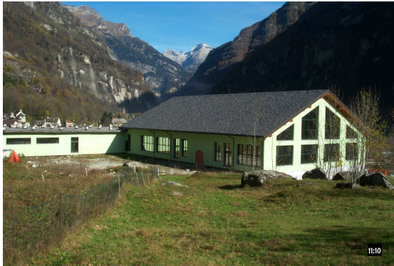
Foto pre intervento
