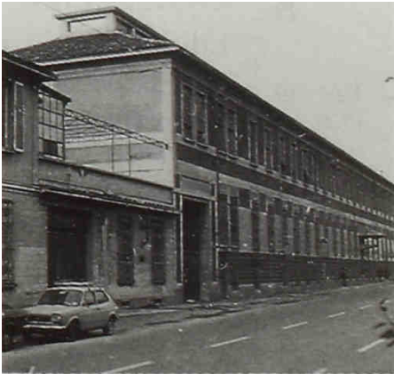
Foto pre intervento
