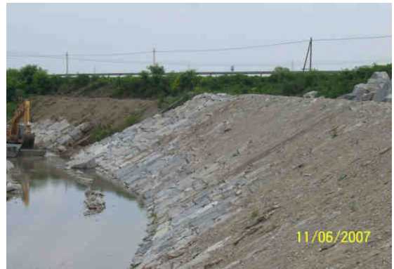
Foto post intervento
