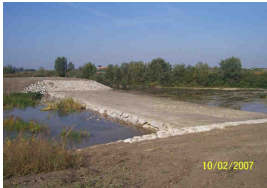
Foto post intervento
