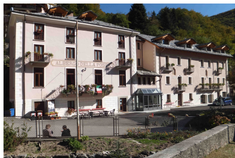
Foto post intervento
