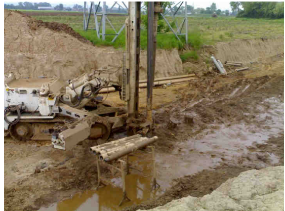
Foto pre intervento
