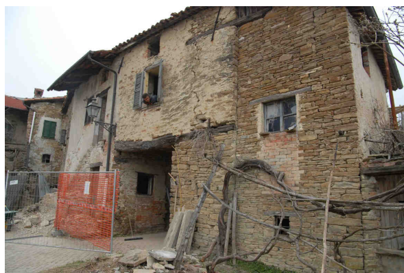
Foto pre intervento
