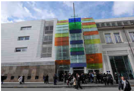
Foto post intervento
