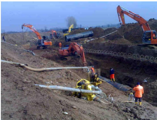
Foto post intervento
