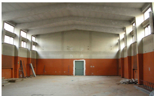
Vista interna locale ex palestra prima dell'intervento
