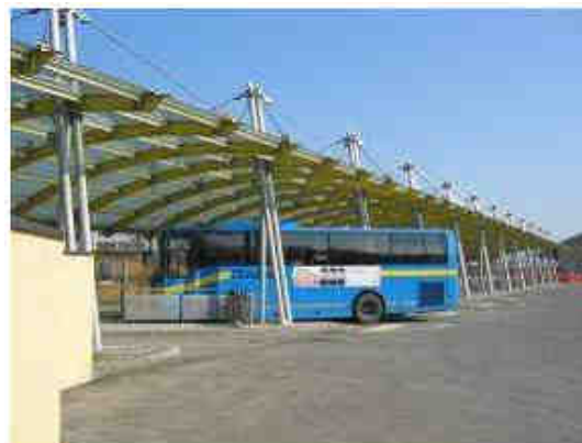
Foto post intervento
