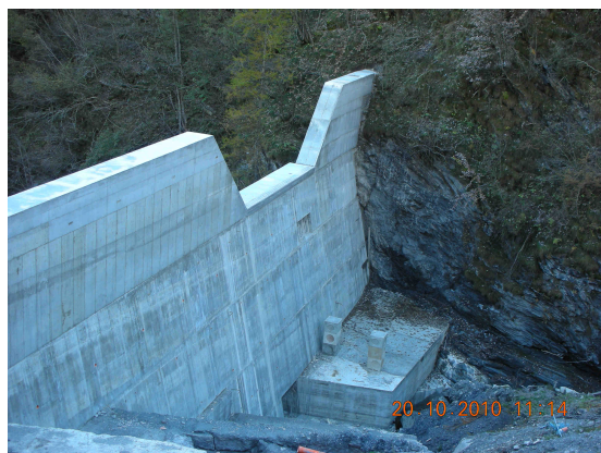
Foto post intervento
