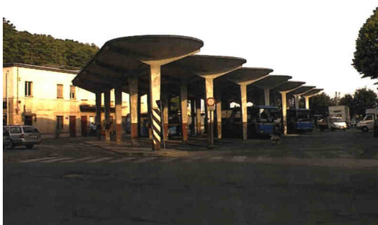
Foto pre intervento
