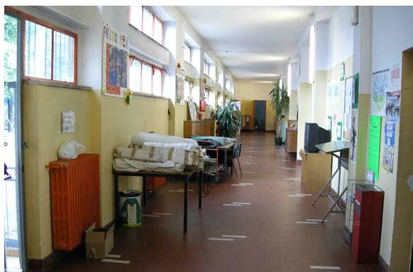
Vista interna sala lettura piano terra prima delle opere
