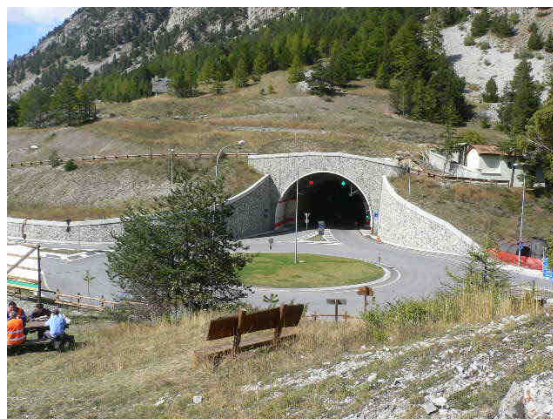
Foto post intervento
