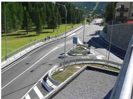
Foto post intervento
