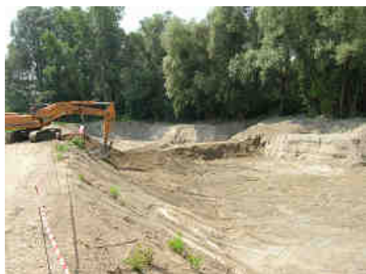
Foto pre intervento
