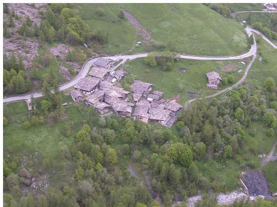
Foto pre intervento
