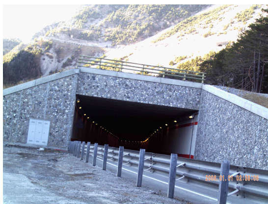
Foto post intervento
