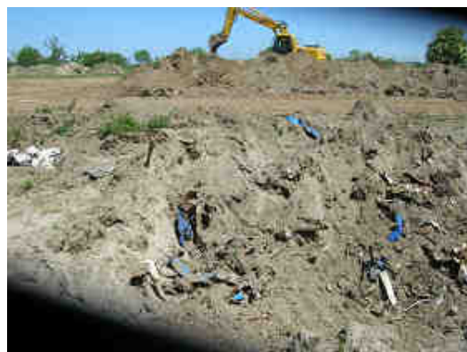
Foto pre intervento
