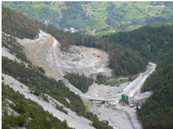
Foto intervento in corso
