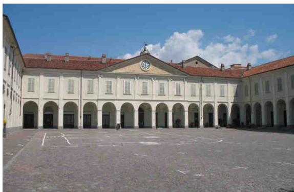
Piazza Ottinetti dopo l'intervento
