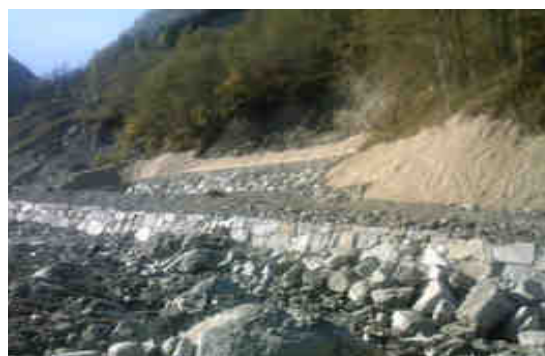
Foto post intervento: protezione delle sponde del fiume
