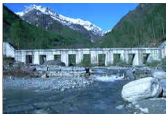
Foto post intervento: realizzazione della briglia selettiva
