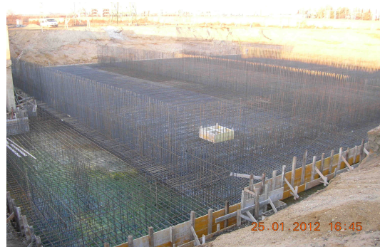
Foto durante l'intervento
