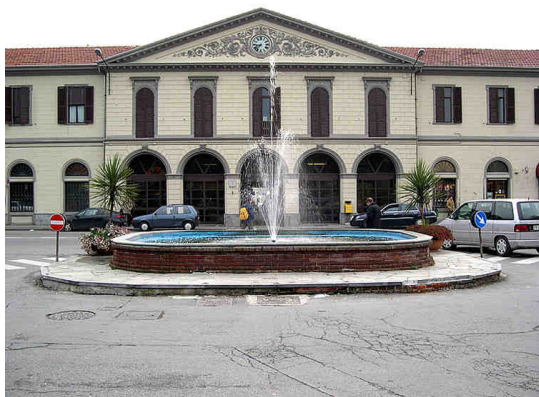
Foto pre intervento
