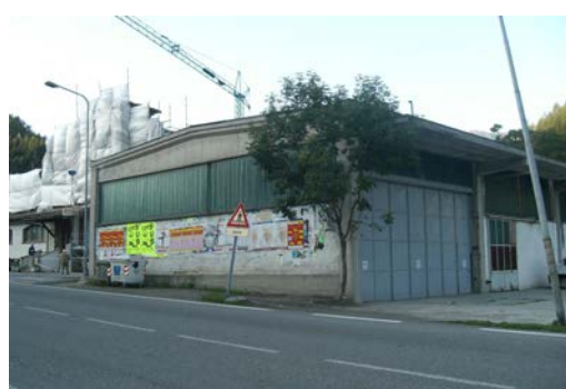
Foto pre intervento fabbricato principale lato Strada Statale 20
