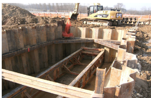
Approntamento cantiere per attraversamento multiplo
