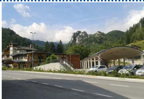
Visione d'insieme da valle lungo Strada Statale 20
