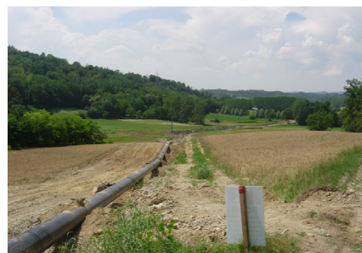
Situazione dei luoghi durante la posa della condotta
