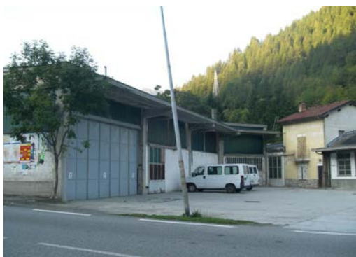
Foto pre intervento fabbricato principale lato cortile
