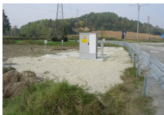
Località Ponte Rosso situazione a lavori ultimati
