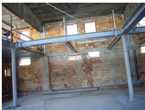
Fabbricato principale in corso d'opera
