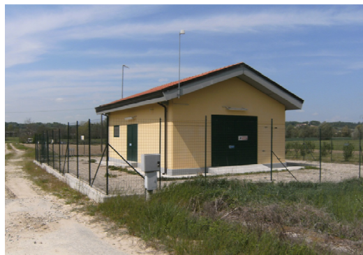
Località Casa Coppi situazione ad intervento realizzato
