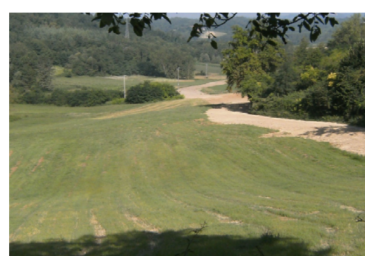
Situazione dei luoghi dopo la posa della condotta
