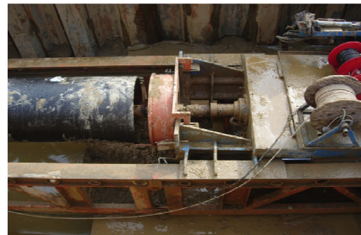
Realizzazione attraversamento multiplo
