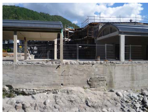
Prospetto lato Torrente Vermenagna dopo demolizioni
