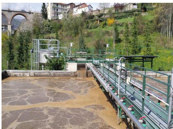
Foto dopo l'intervento
