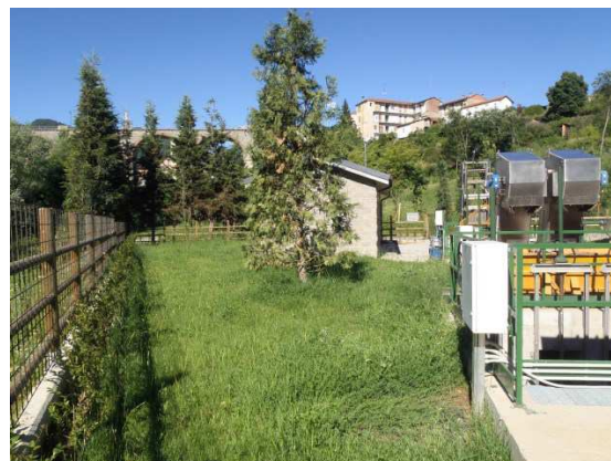
Foto dopo l'intervento
