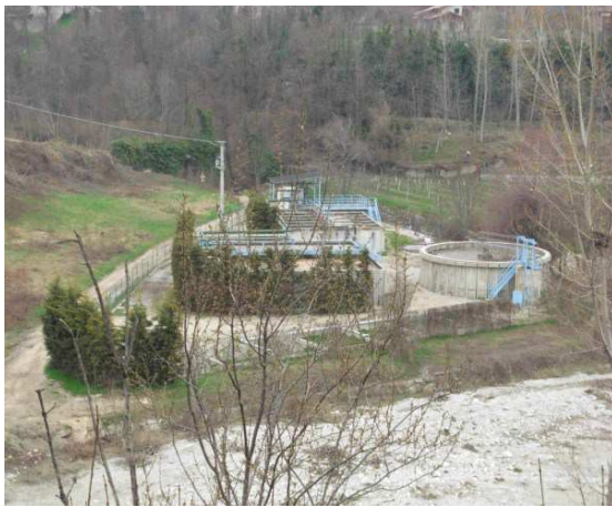
Foto prima dell'intervento
