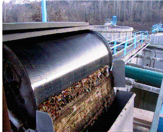
Foto prima dell'intervento
