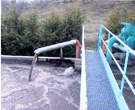
Foto prima dell'intervento
