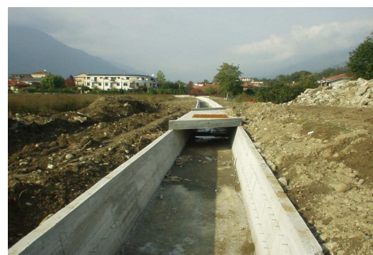
DOPO Tratto del canale in fase di lavorazione
