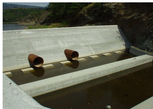
DOPO - Sbarramento Lago Pistono – Inizio canale Roggia del Molino
