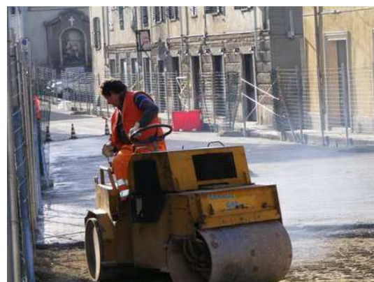
Rullatura sottofondo stradale
