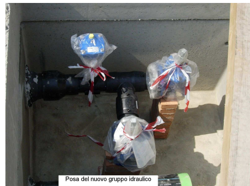
Posa del nuovo gruppo idraulico
