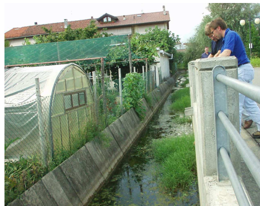
PRIMA - Tratto del canale nel centro abitato prima dell'esecuzione dei lavori
