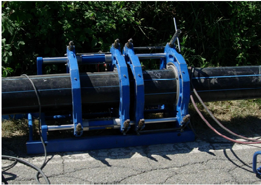
Saldatura in linea delle tubazioni
