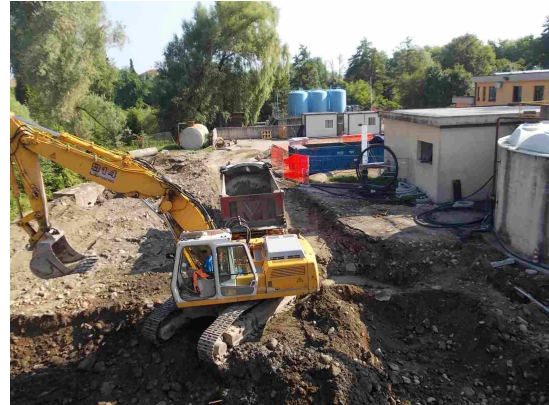
Foto prima dell'intervento
