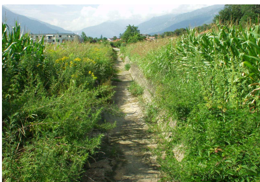
PRIMA - Roggia già esistente prima dei lavori
