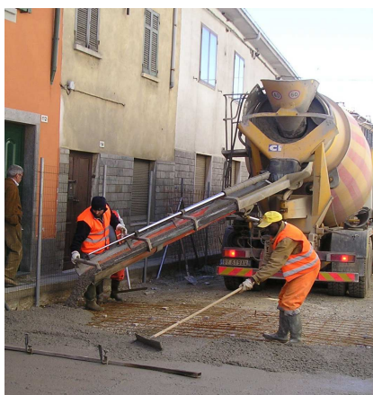
Armatura e getto soletta di sottofondo stradale
