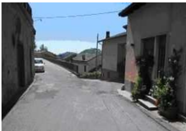
Ripristino pavimentazione bituminosa in Treville
