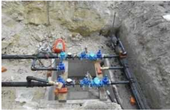
Gruppo idraulico lungo rete adduzione per Cellamonte
