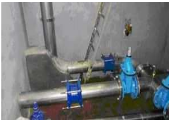
Gruppo idraulico lungo rete adduzione per Cellamonte
