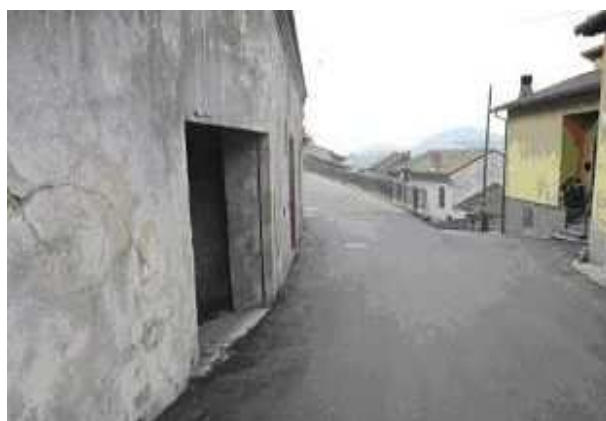
Ripristino pavimentazione bituminosa in Treville
