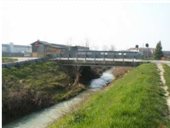
Pre-intervento zona muro di difesa su platea e protezione spondale
