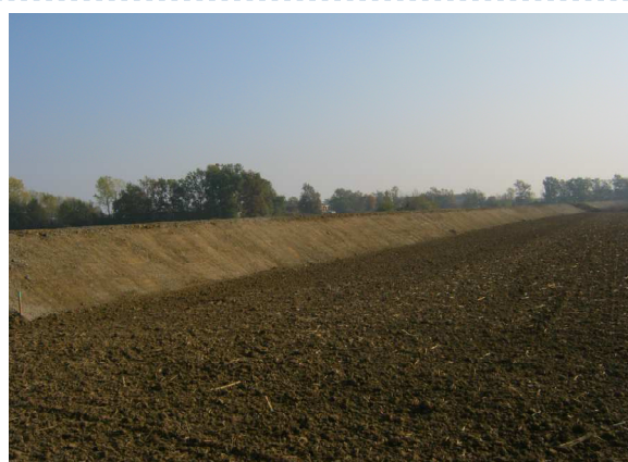
Intervento in corso di realizzazione
