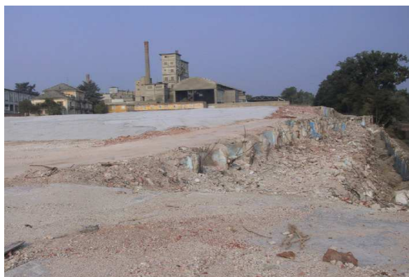
Foto prima dell'intervento (dopo la bonifica e demolizione della fabbrica, conclusa nel 2006)
