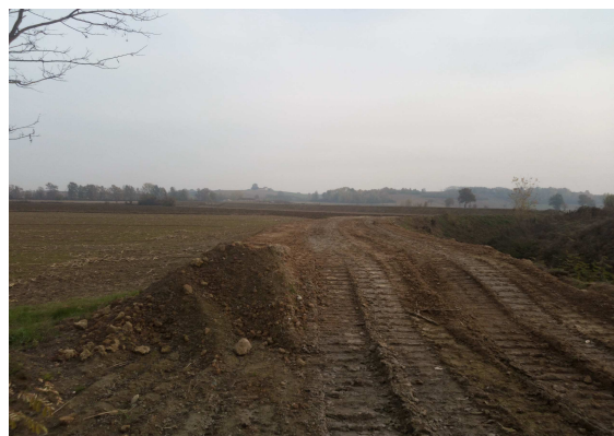
Intervento in corso zona rilevato arginale in terra
