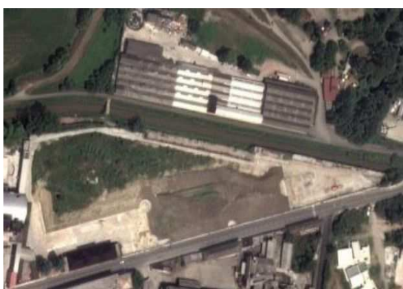
Foto durante i lavori
