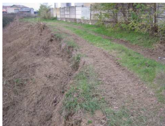
Intervento in corso zona muro di difesa su platea
