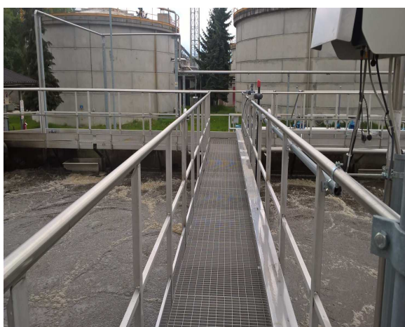
Foto dopo l'intervento
